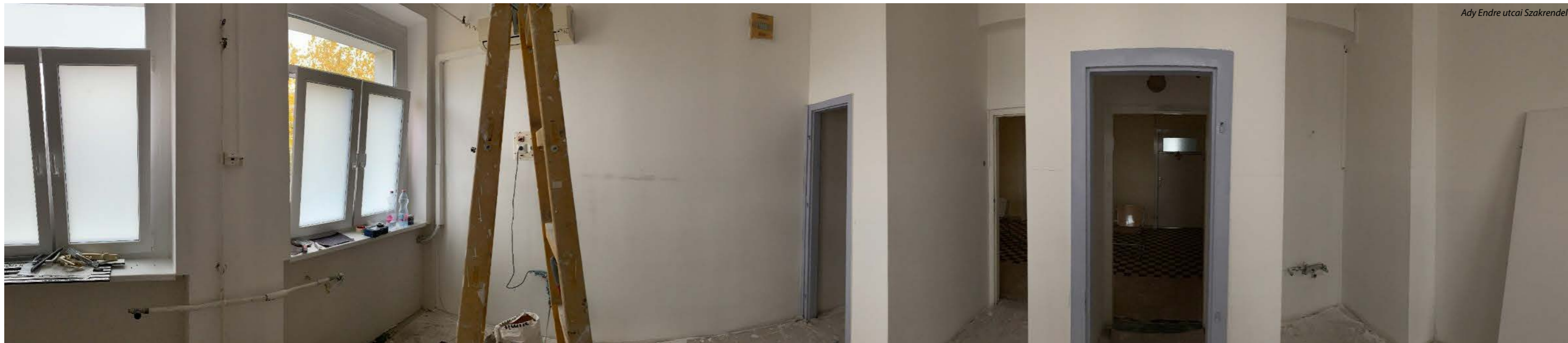
Ady Endre utcai Szakrendelő
